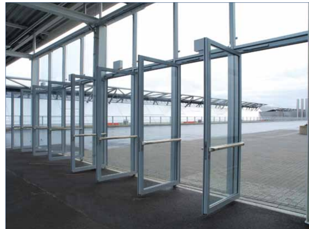
TS 5000 met T-Stop glijrail, Messe Stuttgart
